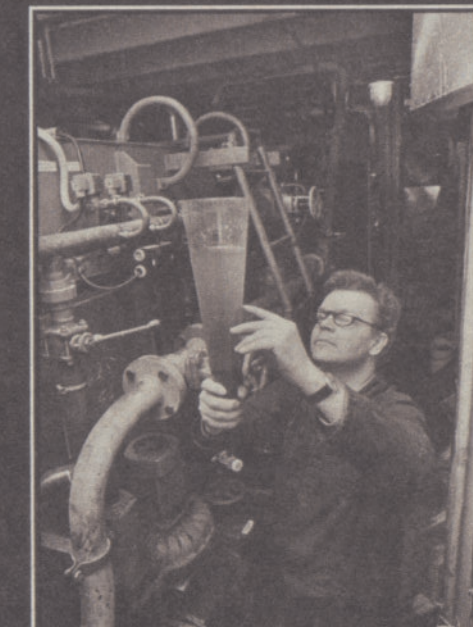
Walter Schlörcke: »Die neu entwickelte Abwasserbehandlungsanlage KAREA 25 hat eine Kapazität von 25 000 Litern am Tag. Diese Menge geht gereinigt ins Meer. Bestmögliches für den Umweltschutz – das war eine Forderung des Auftraggebers.«
