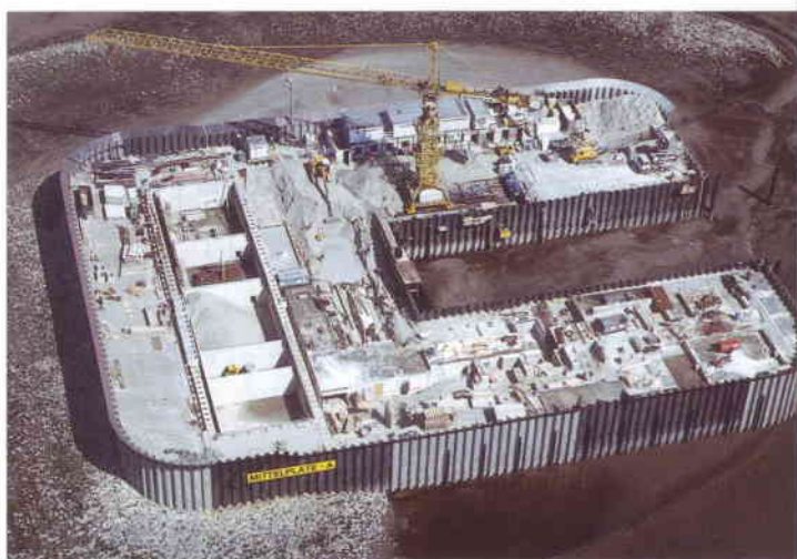
Blick auf die Insel in der Bauphase. Deutlich ist die Wannenkonstruktion mit der betonierten Inseloberfläche und den Spundwänden zu erkennen. Sicherheit gegen alle Naturgewalten von außen und zuverlässige Abschottung nach außen zum Schutz der Umwelt.
