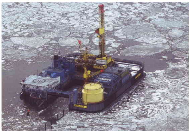
Die kompakte Konstruktion der Bohr- und Förderinsel hat sich auch unter ungünstigen Eisbedingungen bewährt.
